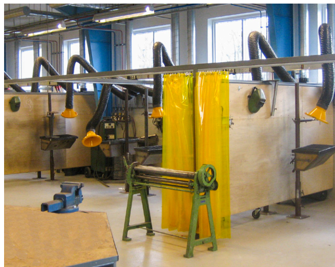
Wing arme ø160mm 3m installeret på teknisk skole. Inkl. Automatik for automatisk start/stop af ventilator og motorspjæld
